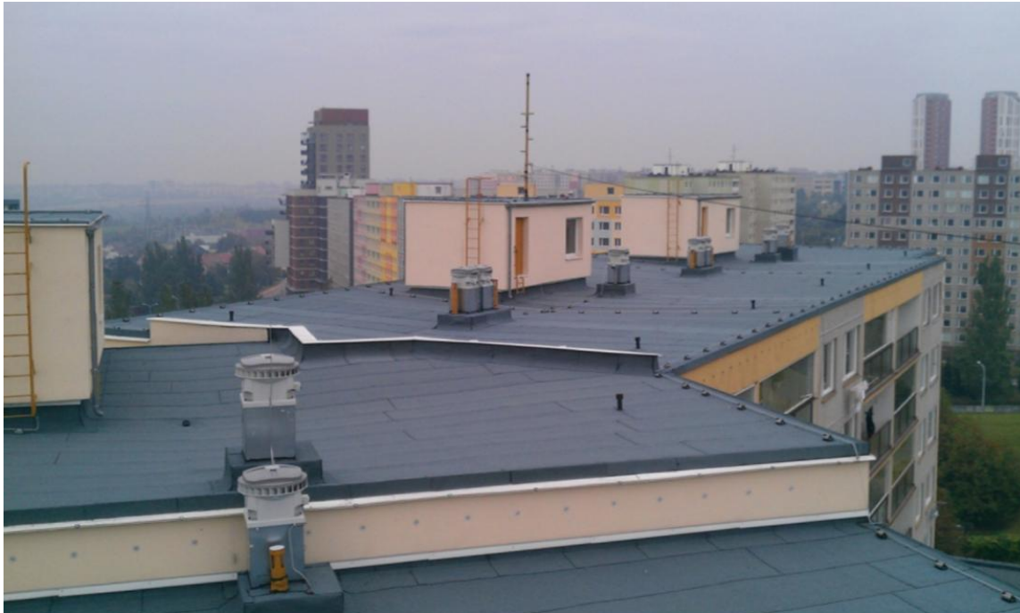
Obrázek 18: Střešní prostor na instalaci FV panelů 11
